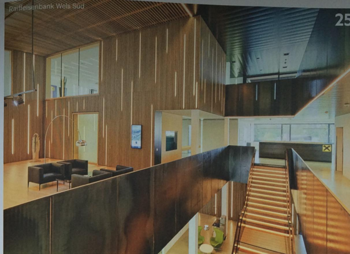
Eine frei stehende Treppe führt in die oberen Räumlichkeiten. Ihr Grundgerüst besteht aus Stahlblechstufen, die Tritt- und Setzstufen wurden in Span P5 ausgeführt, in Eiche furniert und mattiert. Seitlich begrenzt wird diese gesamte Konstruktion von Treppentwangen aus Schwarzstahl. Die Räume zwischen den Stufen füllen satinierte Plexiglaseinlagen mit dahinter gelegenen LED-Bändern mit warmweißem Licht.
